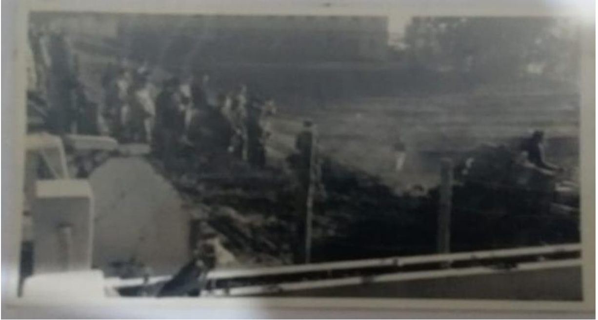
Figura 3 - Construção do novo espaço para a Escola São Luiz Gonzaga
