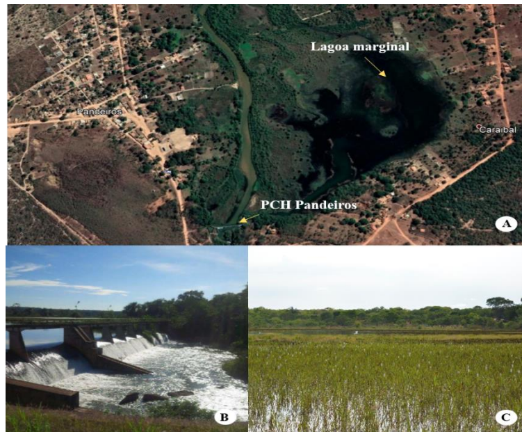
Figura 4 – Lagoa marginal lateral a Pequena Central Hidrelétrica Pandeiros, MG. A) visão aérea da PCH Pandeiros e sua lagoa marginal, B) PCH Pandeiros com vertimento de água em sua crista livre e C) lagoa lateral ao rio Pandeiros.
