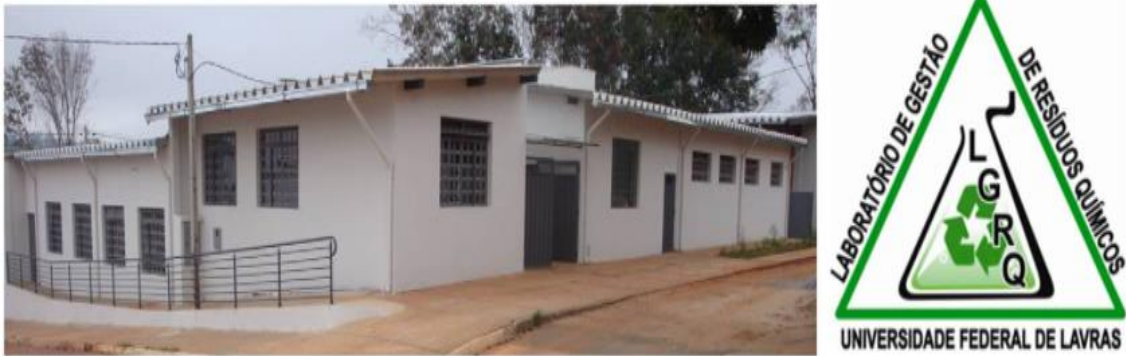
Figura 10 - Setor resíduos químicos-UFLA.
