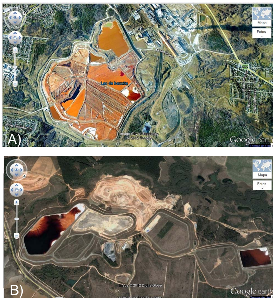
Figura 1 Imagens de alta resolução obtidas pelo Google Earth™. A) Posto de operação da Rio Tinto Alcan's Jonquiére, Quebec, Canadá. B) Posto de operação da ALCOA, em Poços de Caldas, Minas Gerais, Brasil
