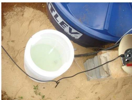
Figura 2 Injeção de coagulante
