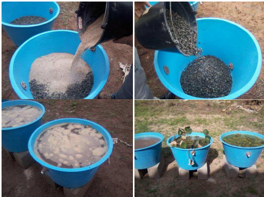
Figura 11 Montagem dos wetlands construídos
