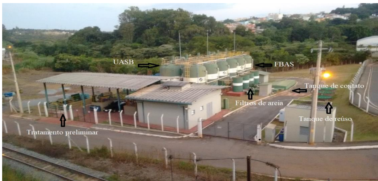
Figura 3 - Unidades de tratamento da ETE-UFLA.
