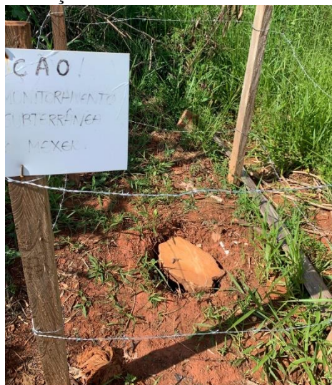
Figura 8 – Poço P2 com estrutura danificada.
