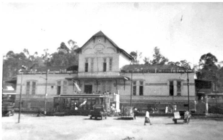
Figura 18 A Estação de Lavras após sua ampliação, na década de 1930, que não alterou sua fachada (1940)
