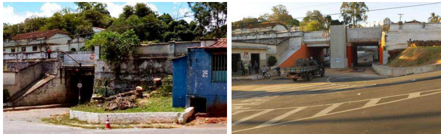
(a) (b) Túnel da Zona Norte antes e após as obras de ampliação Fonte: (INAUGURADO..., 2014)
