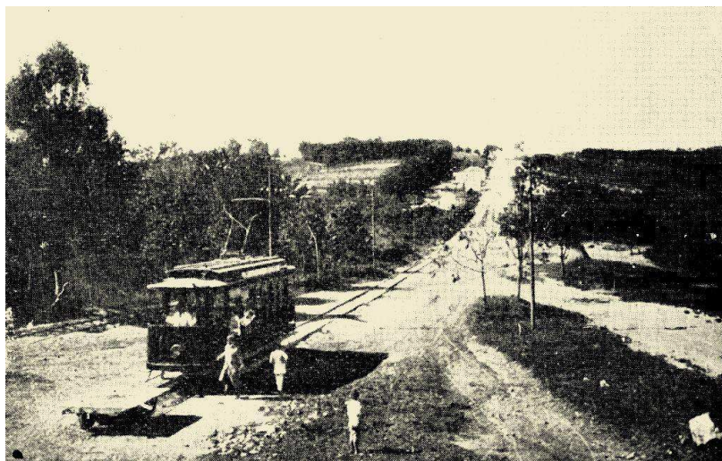
Figura 24 Bonde no local onde futuramente seria implantada a Praça Dr. José Esteves.
