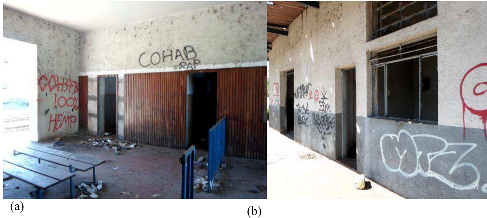
Figura 48 (a) (b) Dependências internas do prédio da Estação de Lavras. (a) Interior do prédio (b) Lado do prédio voltado para a linha férrea.
