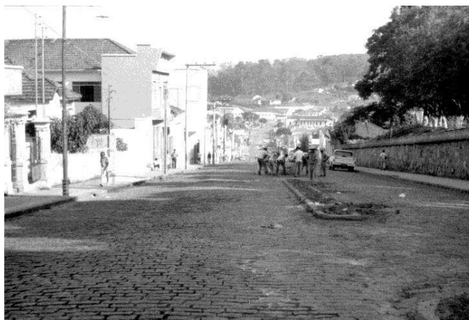
Figura 10 Construção de canteiros no lugar dos antigos trilhos do bonde, na altura do antigo castelinho da Avenida Pedro Salles (1969)
