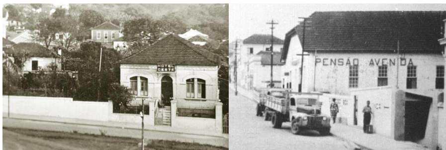
Figura 14 (a) Fachada do Hotel Oeste, localizado na Praça Dr. José Esteves (b) Lateral do prédio da Pensão Avenida, localizado na Avenida Pedro Salles
