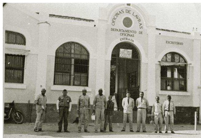
Figura 23 Entrada dos galpões das oficinas mecânicas de Lavras
