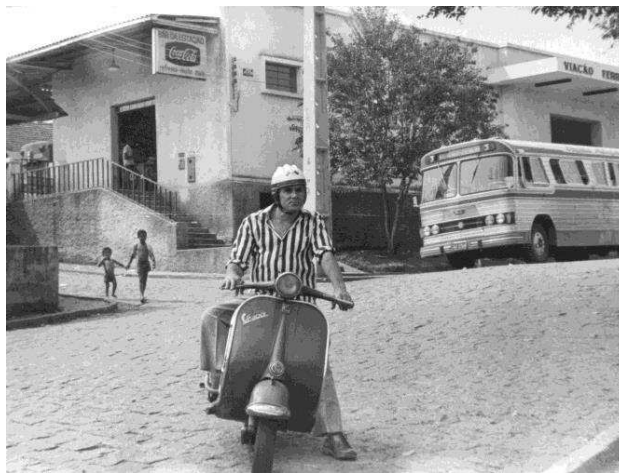
Figura 20 A fachada da Estação de Lavras após a reforma ocorrida em 1969
