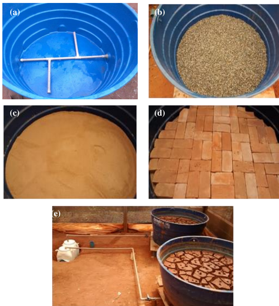
Figura 5 Etapas da montagem do leito de secagem para desidratação do resíduo: (a) reservatório de polietileno, com os drenos de PVC; (b) camada de brita; (c) camada de areia; (d) camada de tijolo refratário; e (e) distribuição dos leitos de secagem em uso e dos reservatórios para coleta do percolado
