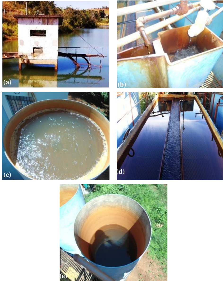
Figura 4 Diferentes unidades que compõem o sistema de abastecimento de água para consumo humano na UFLA: (a) captação, (b) calha Parshall, (c) floculador, (d) decantador, e (e) filtro
