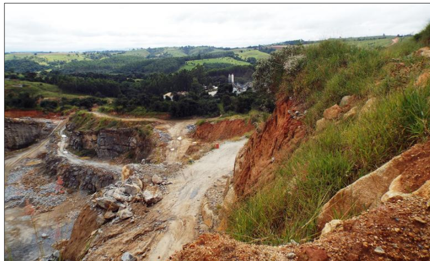
Figura 4 - Detalhe da Cava e bancada de exploração.
