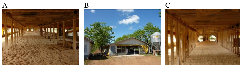
Figura 2 - Visão (A) interna, (B) externa e (C) detalhe dos exaustores no aviário sistema Pressão Negativa.
