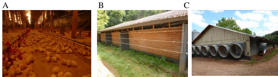
Figura 3 - Visão (A) interna, (B) externa e (C) detalhe dos exaustores no aviário sistema dark house .
