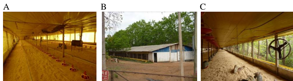
Figura 1 - Visão (A) interna, (B) externa e (C) detalhe do ventilador no aviário sistema convencional.
