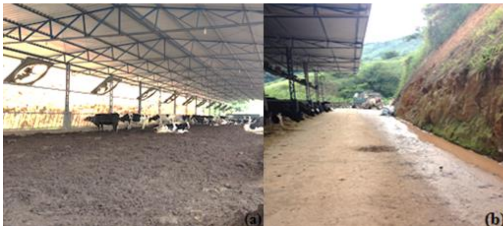
Figura 1 - Face leste do sistema compost barn: (a) ventiladores e cama (b) corredor de alimentação, fazenda 1, município de Itamonte, Minas Gerais
