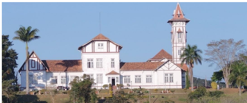
Figura 15 - Fachada principal do prédio sede do IFSUDESTE MG – câmpus Barbacena.
