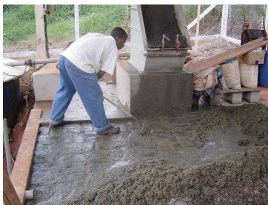
Figura 7 Detalhe da disposição dos dejetos na parte superior do LDS
