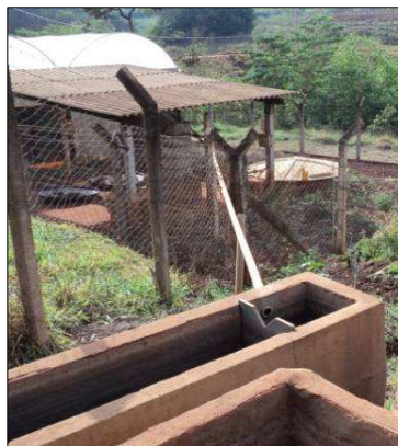
Figura 6b Vista lateral do mesmo aparato mostrando a ligação entre a caixa de areia e peneira estática por meio de tubulação aérea
