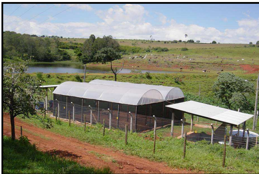
Figura 3 Sistema de tratamento montado na área do Departamento de Zootecnia da Universidade Federal de Lavras – DZO/UFLA.
