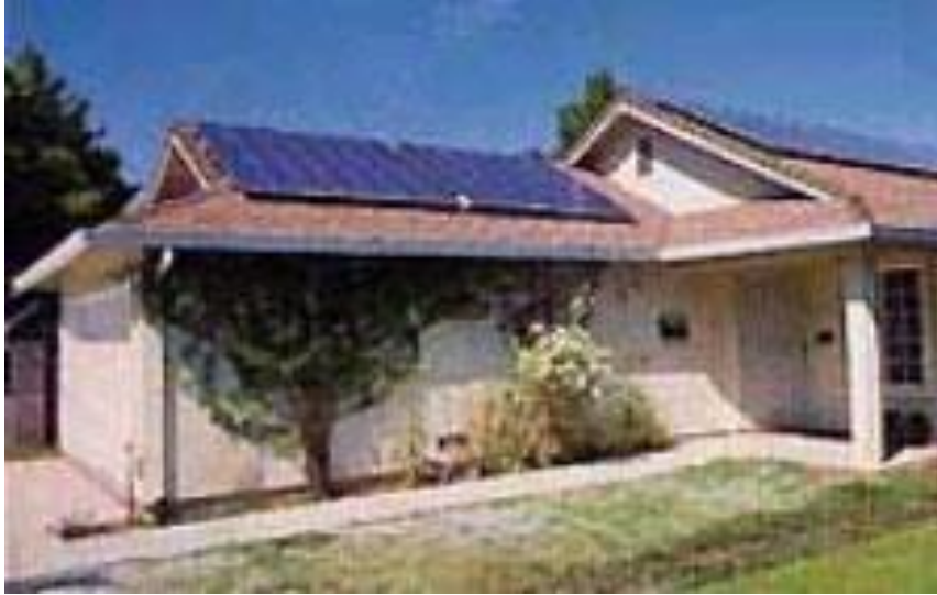
Figura 02: Equipamentos fotovoltaicos para telhados 1
