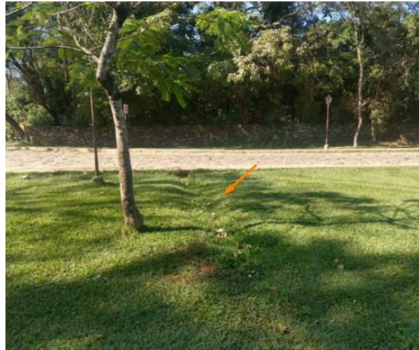
Figura 11 - Valetas para drenagem da água pluvial no Largo das Mercês em 2021.
