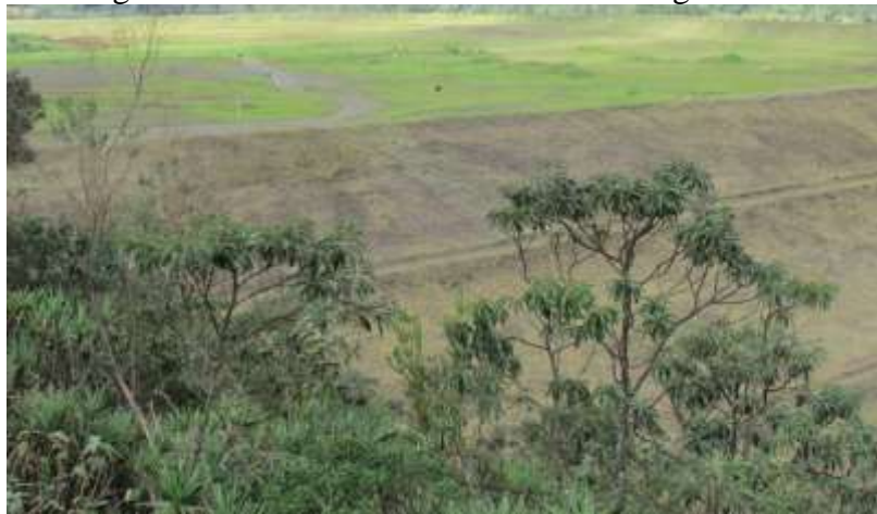
Figura 35 – Vista do reservatório da Barragem XRS
