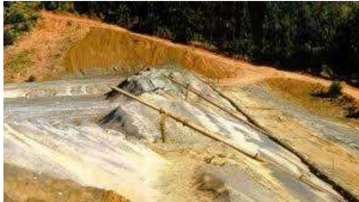
Figura 4 – Lançamento e deposição de rejeitos granulares através de canhões
