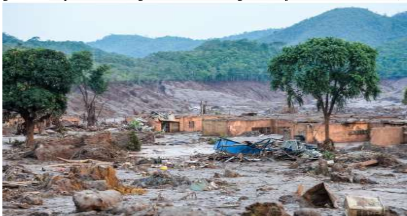
Figura 6 – Ruptura da Barragem da mina Córrego do Feijão, em Brumadinho (MG)
