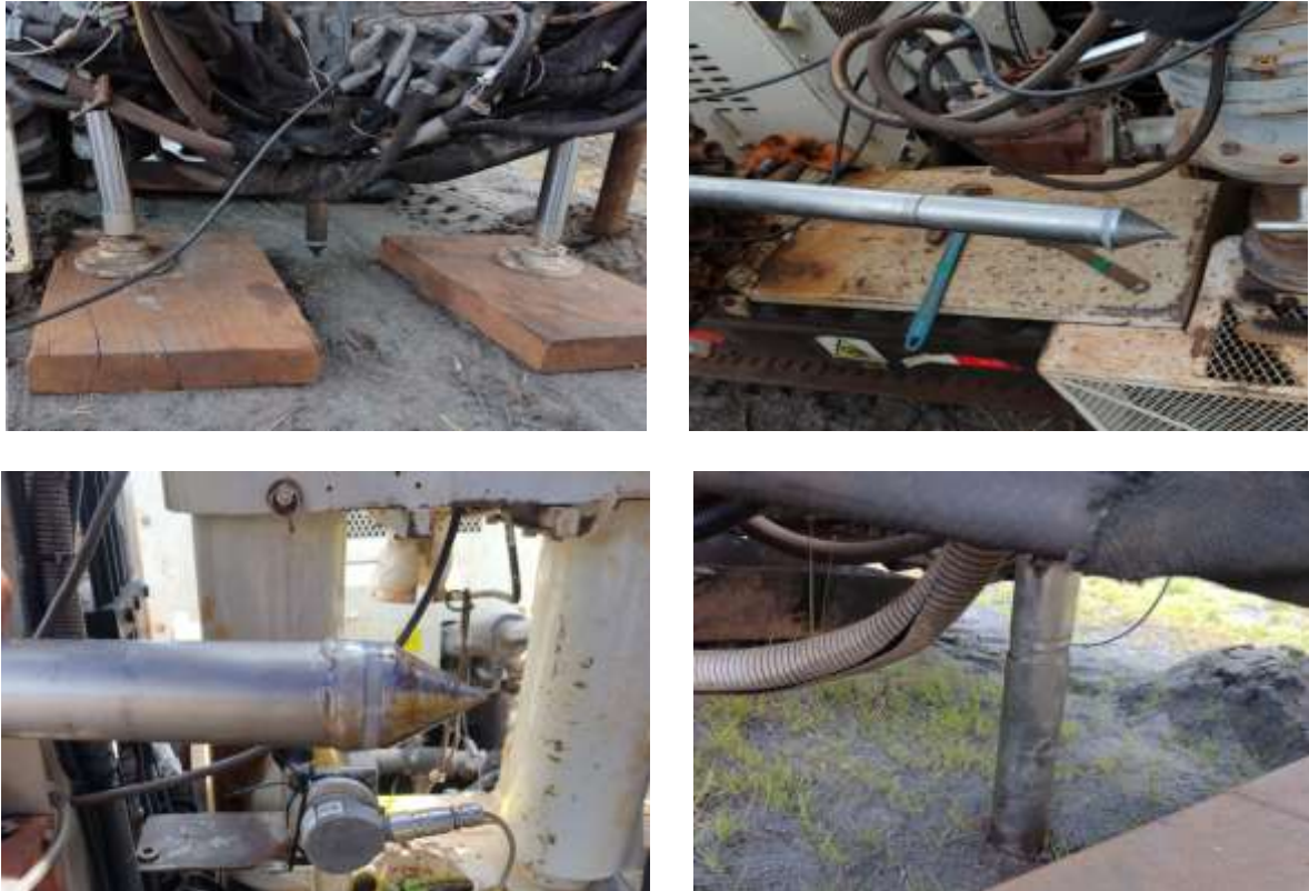
Figura 10 – Execução do ensaio do Piezocone na Barragem XRS
