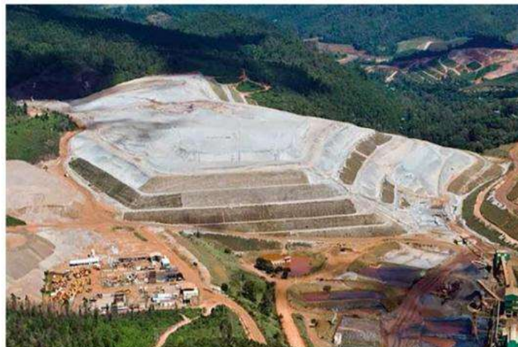
Figura 5 – Depósito de rejeito pelo método de empilhamento drenado
