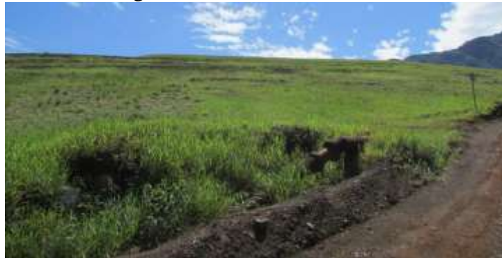
Figura 28 – Vista do Talude B2
