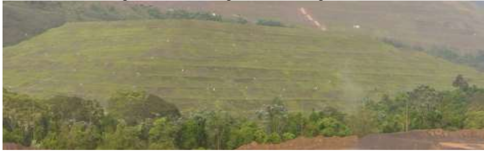
Figura 12 – Vista geral da Barragem XRS
