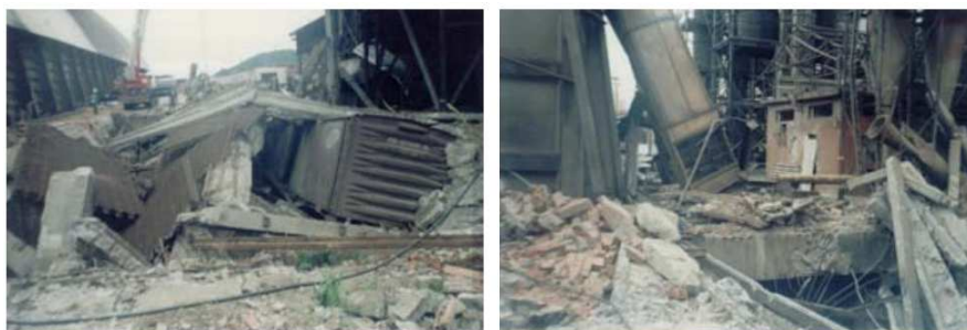
Figura 6 Explosões por excesso de poeira de cereais em suspensão e uma pequena centelha elétrica
