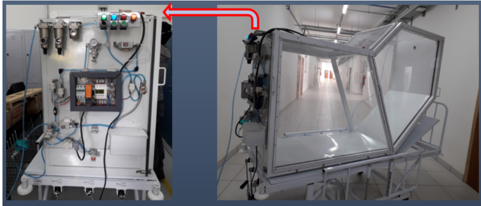
Figura 4.8 – Visão do painel de controle.
