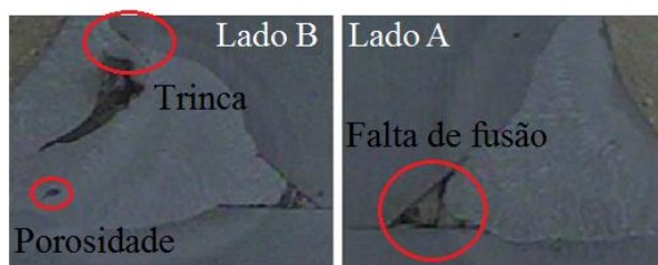
Figura 17 - Detalhe da falta de fusão, trinca e porosidade Fonte: Dos autores (2018).
