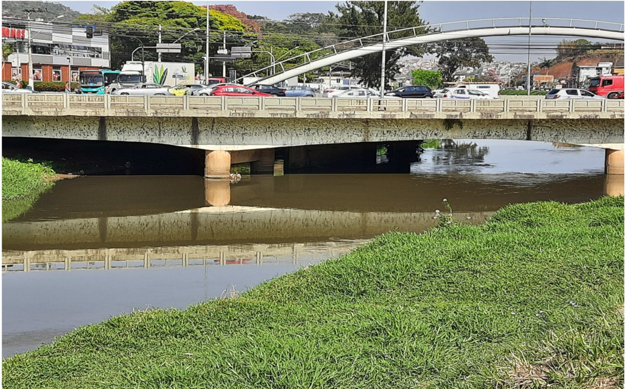
Figura A5: (02/06/2019) Paraibuna montante Córrego Matirumbide. Ponte que corta as avenidas Rio Branco e Brasil, região central da cidade de Juiz de Fora.
