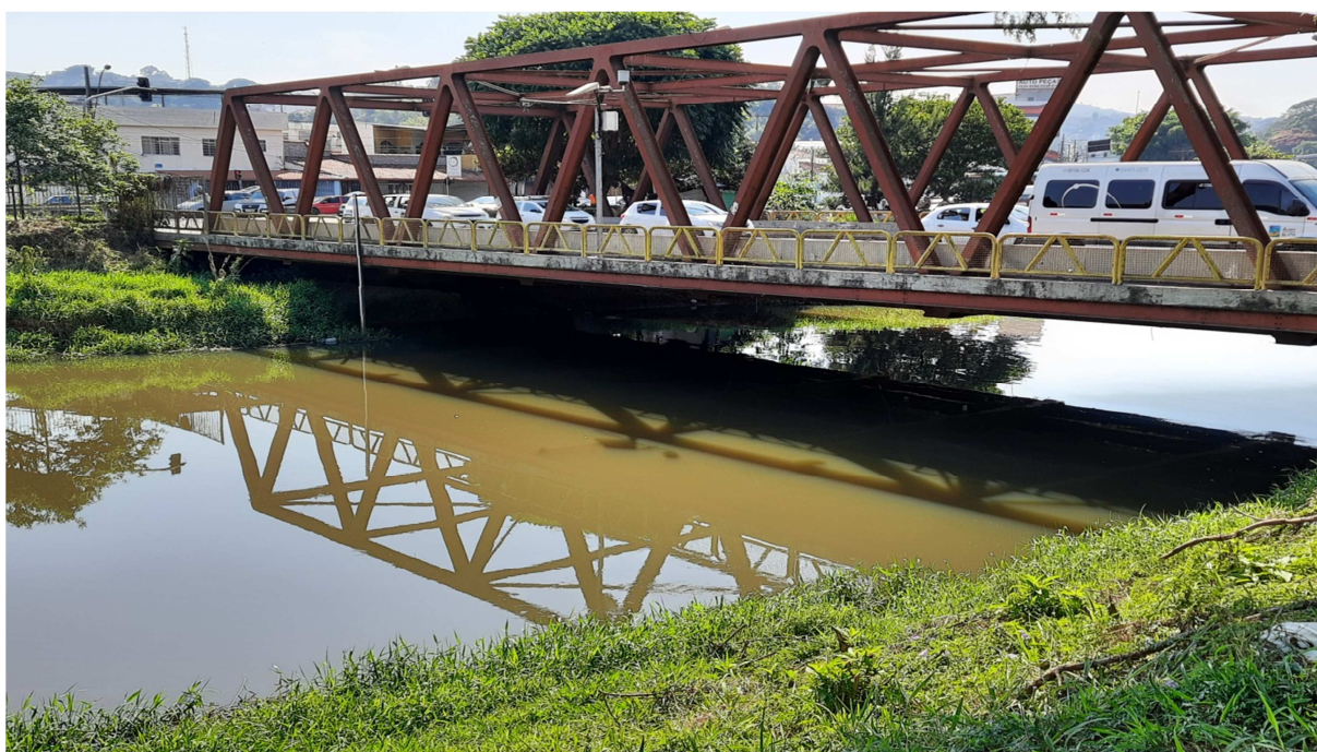
Figura A1: (02/06/2019) Paraibuna – Cabeceira do trecho de estudo – Existe neste ponto uma estação do CEMADEM que monitora o nível do Rio Paraibuna.
