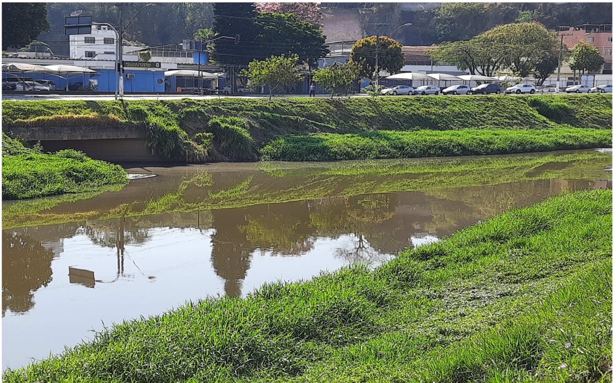
Figura A4: (02/06/2019) Confluência do Córrego Matirumbide com o Rio Paraibuna.
