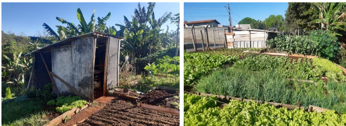
Fotografia 6 - Aproveitamento de madeiras, caibros, telhas, telas e estruturas metálicas para a construção de depósitos
