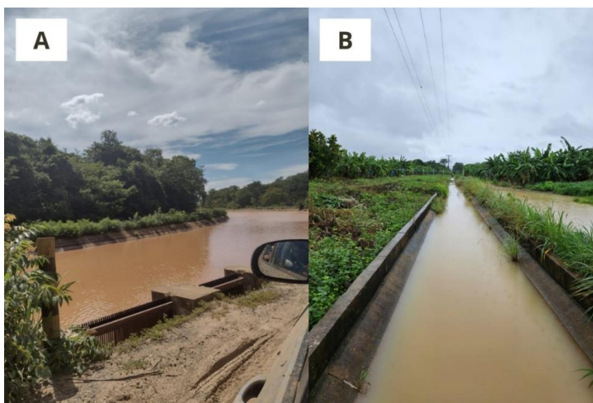
Figura 1- Canais de irrigação do Projeto Jaíba, MG. (A) Canal principal que capta água do rio São Francisco. (B) Canal secundário que leva a água até as plantações. Fonte: Korasaki (2024).
