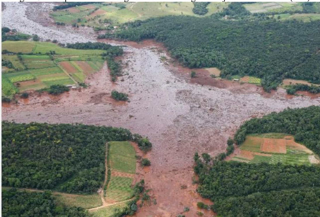
Figura 7– Rompimento da Barragem da Mina Córrego do Feijão em Sobradinho (MG).
