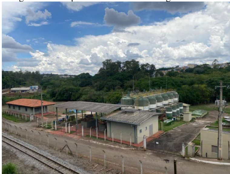
Figura 2 – Estação de Tratamento de Esgoto da UFLA.
