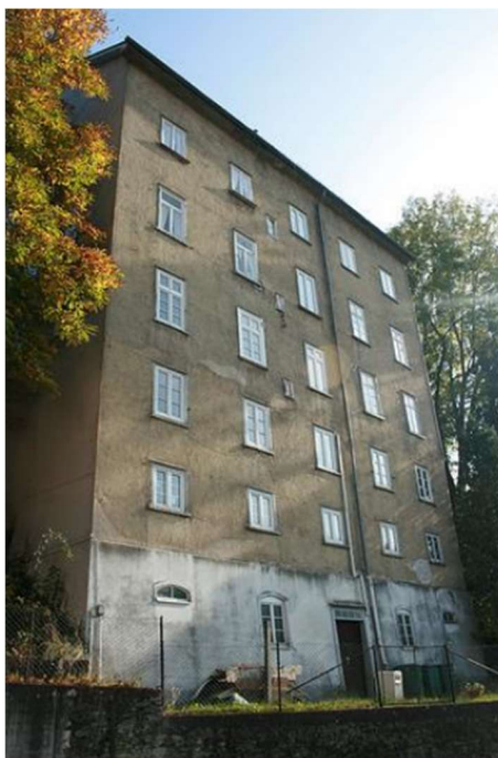
Figura 5 – Haus Rath, edifício de sete andares em terra não estabilizada
