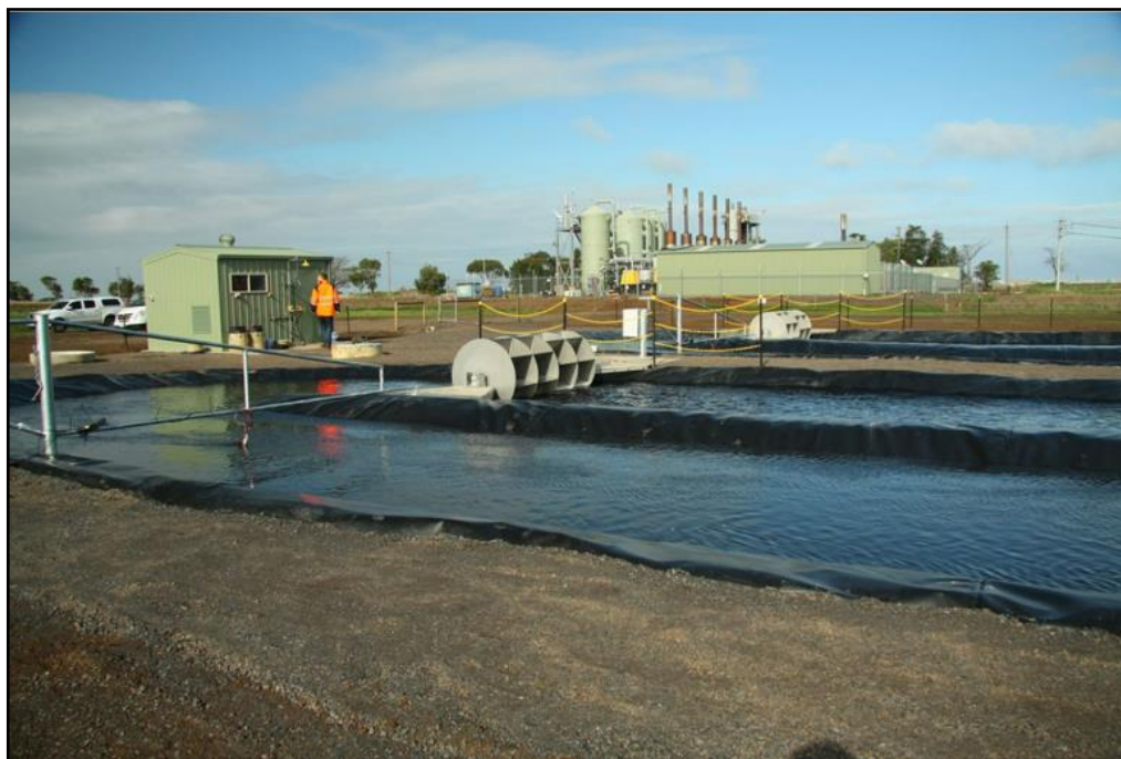
Fig. 1. LATs na Estação de Tratamento de Água de Melbourne, Austrália.
