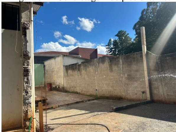
Figura 51 – Concretagem do piso externo.
