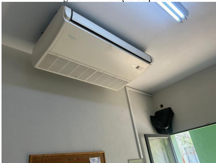
Figura 42 – Furação da parede.
