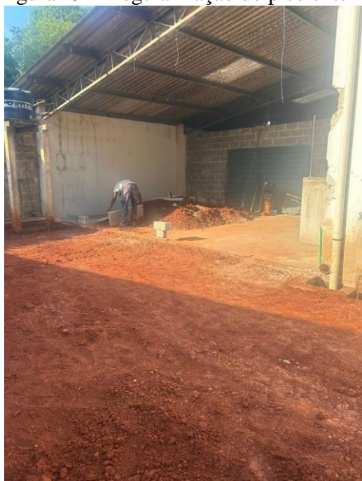
Figura 49 – Regularização do piso externo.
