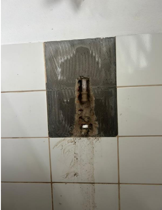
Figura 58 – Substituição da parte danificada.
