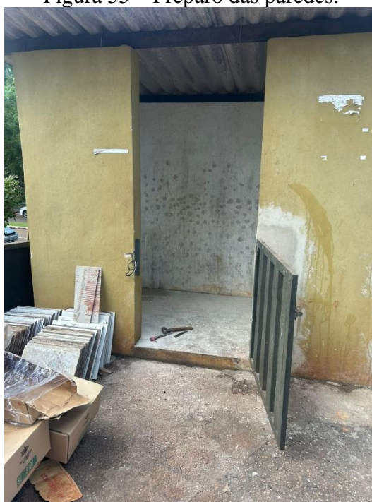
Figura 55 – Preparo das paredes.
