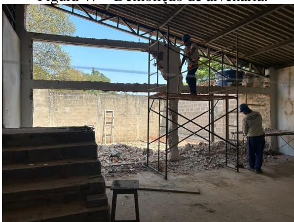
Figura 47 – Demolição de alvenaria.
