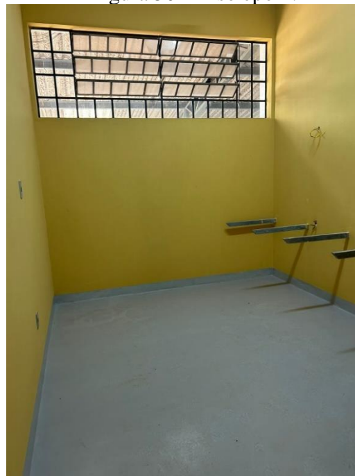
Figura 50 – Piso epóxi.
