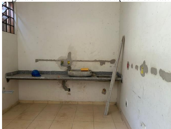
Figura 52 – Bancadas e instalações elétricas.
