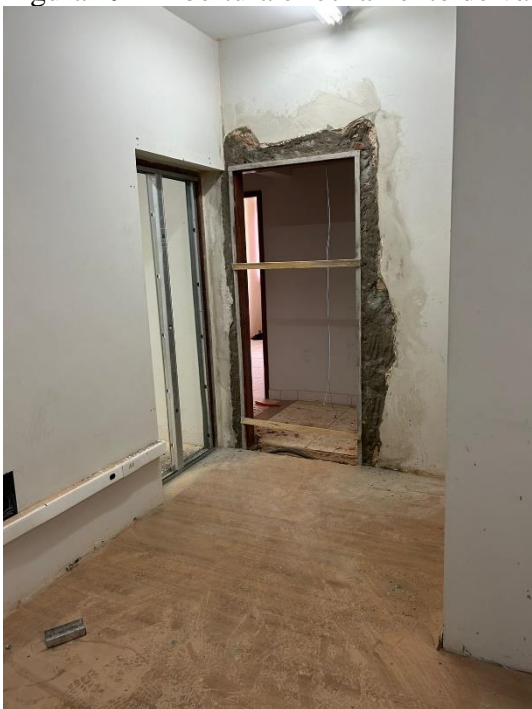
Figura 29 – Abertura e fechamento de vão.
