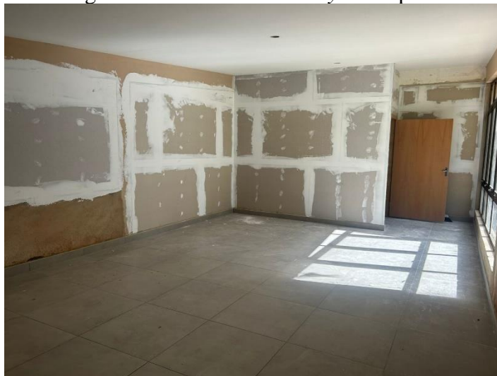
Figura 38 – Divisórias em drywall e piso.
