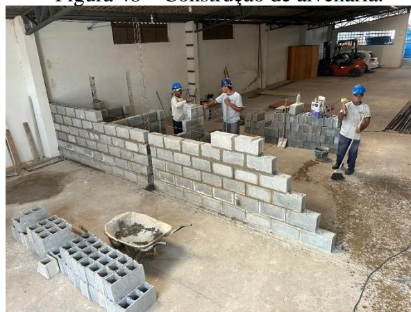
Figura 48 – Construção de alvenaria.
