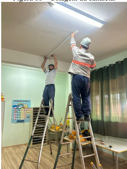
Figura 66 – Colagem da canaleta.
