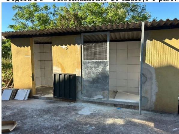
Figura 56 – Assentamento de azulejo e piso.
