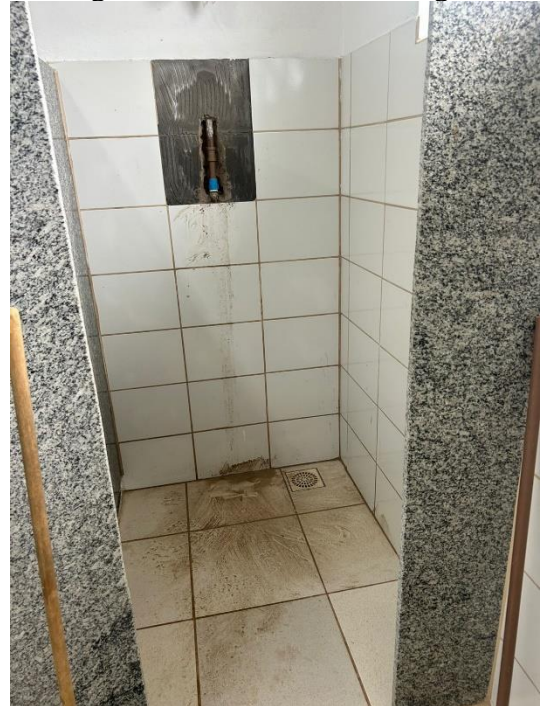
Figura 59 – Vazamento corrigido.
