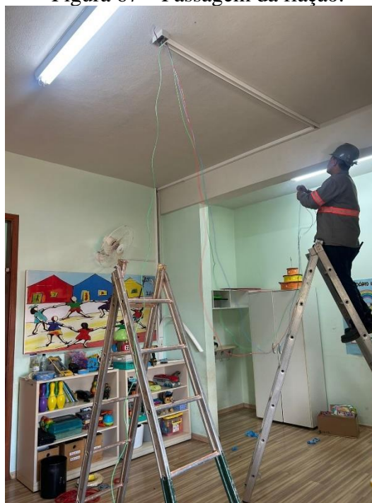
Figura 67 – Passagem da fiação.
