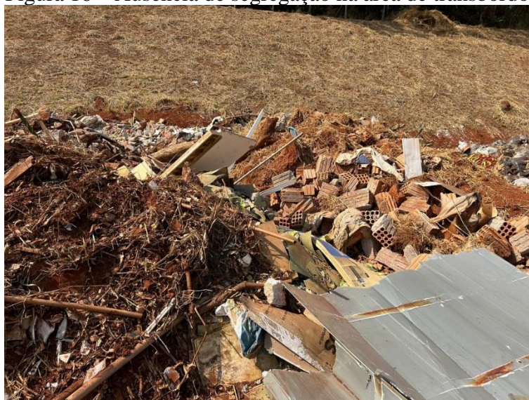
Figura 16 – Ausência de segregação na área de transbordo.
