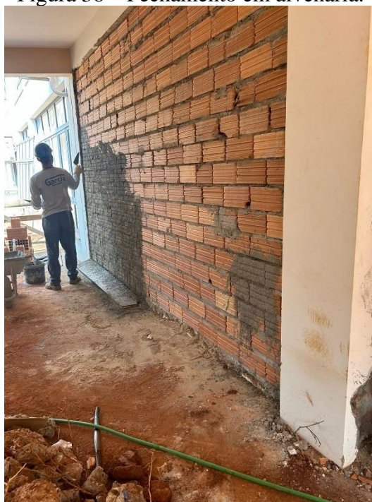
Figura 36 – Fechamento em alvenaria.
