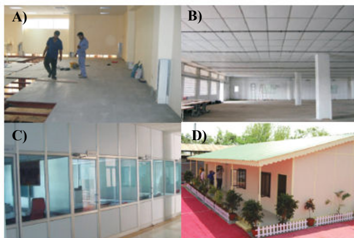
Figura 1 - Aplicações dos painéis de cimento-madeira na construção civil: A) pisos; B) forros; C) paredes divisórias; D) casas pré-fabricadas.
