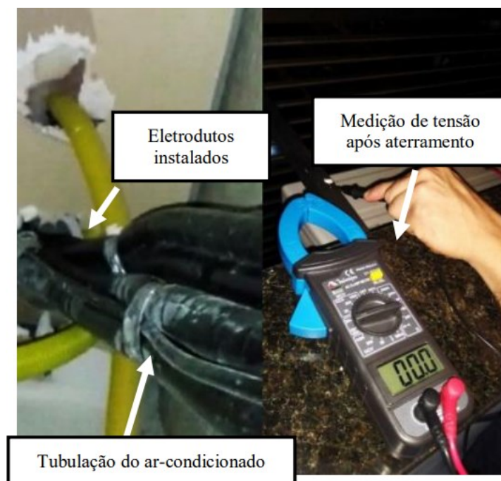
Figura 9 – Eletrodutos instalados e testagem da carcaça.
