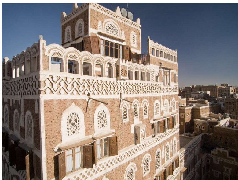
Figura 3 – Construção de adobe na cidade de Sana'a no Iêmen.
