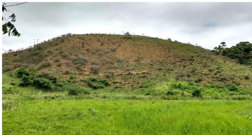
Figura 37 - Vertente convexa com processos erosivos avançados e subsequente deslizamento – Santa Bárbara do Monte Verde. Foto: Felipe Oliveira
