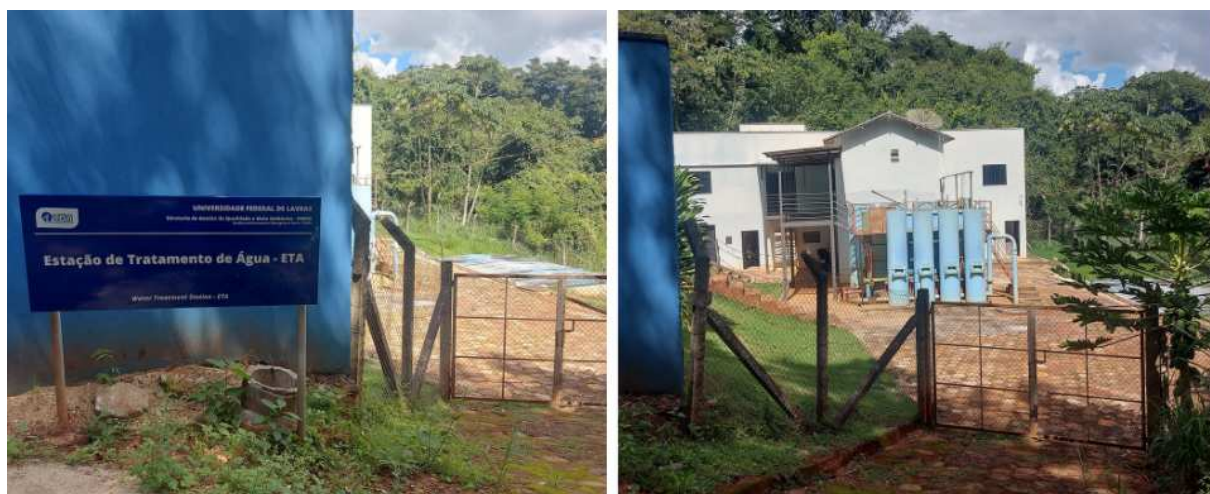
Figura 4.4 – Estação de Tratamento de Água (ETA) da UFLA.
