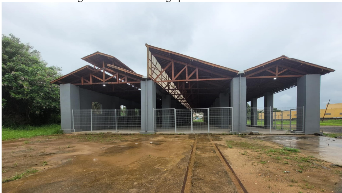
Figura 44 – Fachada do galpão da Rede Ferroviária.
