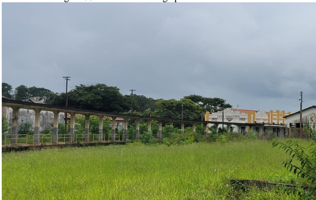
Figura 53 – Lateral da antiga plataforma ferroviária.
