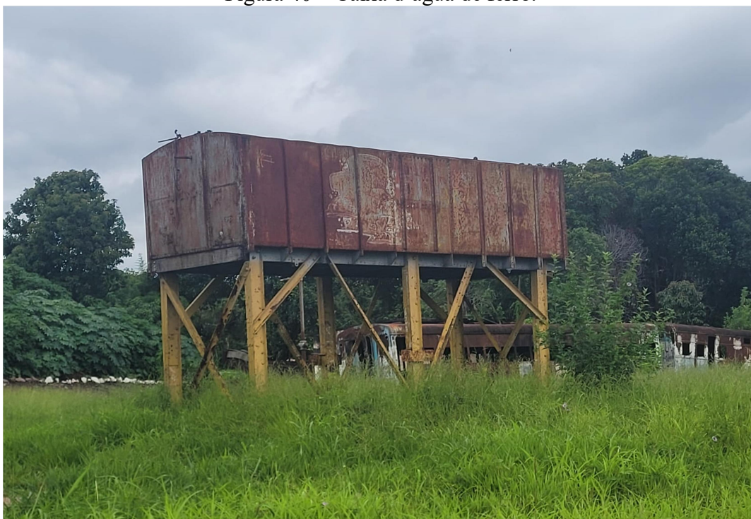
Figura 40 – Caixa d'água de ferro.
