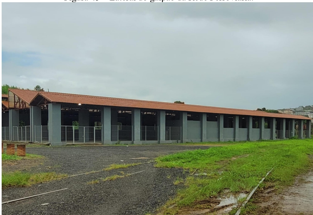
Figura 45 – Lateral do galpão da Rede Ferroviária.
