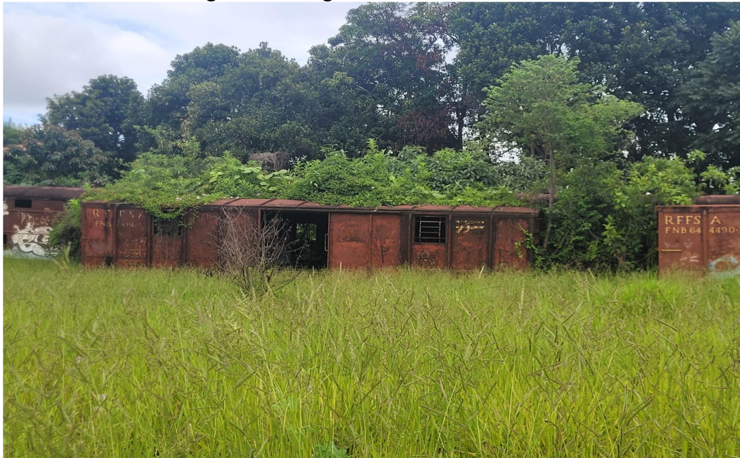
Figura 37 – Vagão da RFFSA em ruínas.
