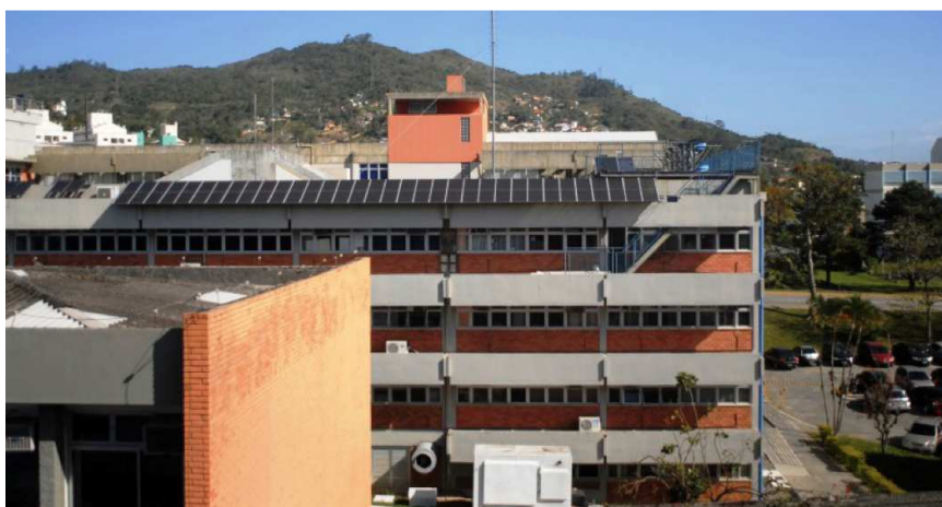
Figura 4 Foto do primeiro sistema fotovoltaico conectado à rede do Brasil usando tecnologia de silício amorfo, instalado na UFSC (BRASIL, 2015b)
