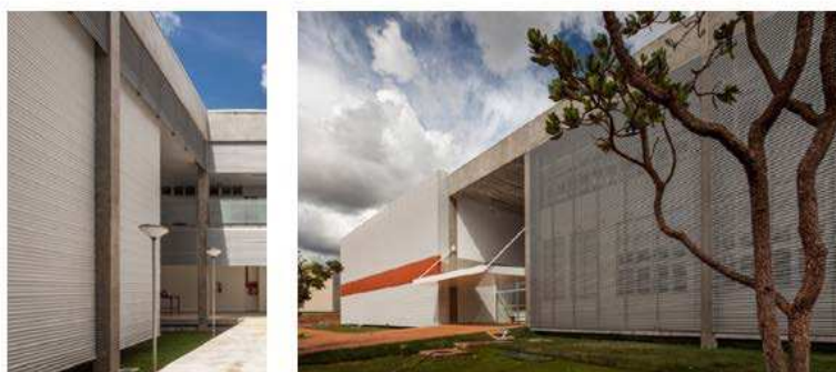
Figura 13 – Uso do brise na Unidade de Ensino e Docência – Ceplan UnB.
