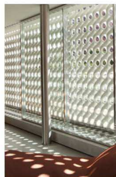
Figura 12 - Utilização de cobogós para melhorar a iluminação e ventilação natural. Projeto de Márcio Kogan.
