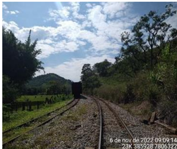
Figura 7: Registro do Trecho 38 realizado na campanha de monitoramento. Fonte: Equipe Vimef (2023).
