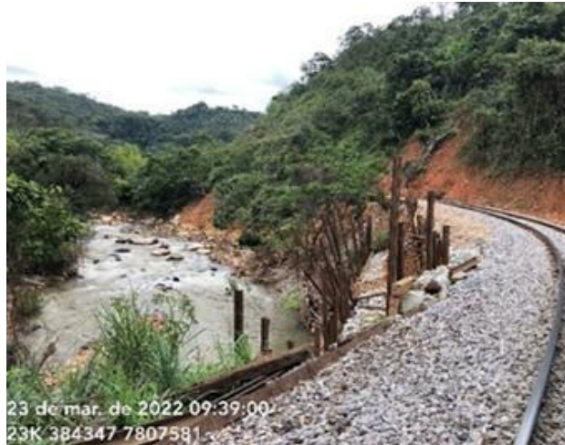
Figura 6: Registro do Trecho 38 realizado na campanha de monitoramento. Fonte: Equipe Vimef (2023).
