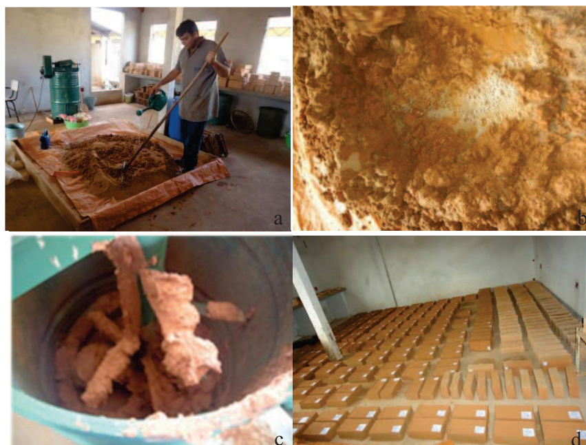
Figura 2 Mistura dos materiais (a); aspecto da “baba de cupim sintética” sobre o solo (b); mistura na maromba (c); e secagem dos adobes (d)
