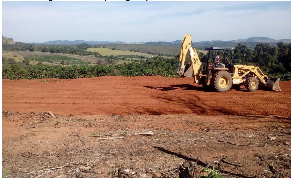
Figura 7 - Terraplanagem para as moradias do PNHR
