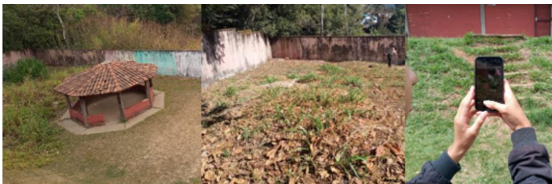
Figura 5 - Registro do terreno evidenciando desnível e ausência de condições de acessibilidade ao espaço externo (Grupo 2)
