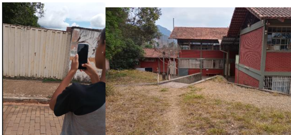
Figura 4 - Registro da entrada da escola evidenciando limitações de acessibilidade (Grupo 1)
