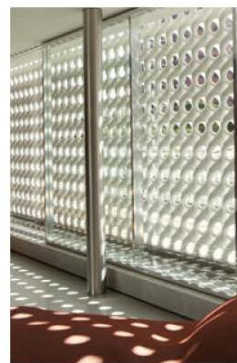
Figura 12 - Utilização de cobogós para melhorar a iluminação e ventilação natural. Projeto de Márcio Kogan.
