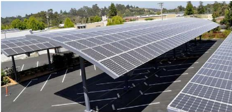
Figura 3 - Painéis fotovoltaicos aliados à arquitetura em coberturas de estacionamentos.
