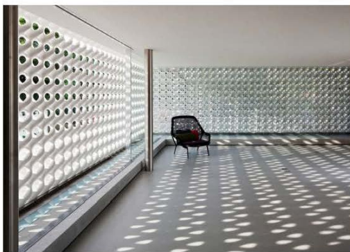
Figura 11 - Utilização de cobogós para melhorar a iluminação e ventilação natural.
