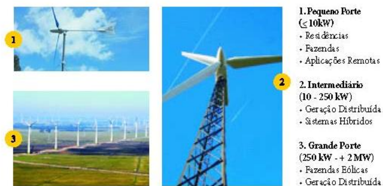
Figura 8 – Diferentes tamanhos e modelos de aerogeradores e indicação das aplicações
