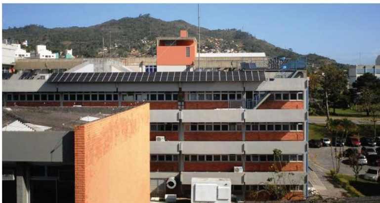
Figura 4 - Primeiro sistema fotovoltaico conectado à rede do Brasil usando tecnologia de silício amorfo, instalado na UFSC, - Florianópolis, SC
