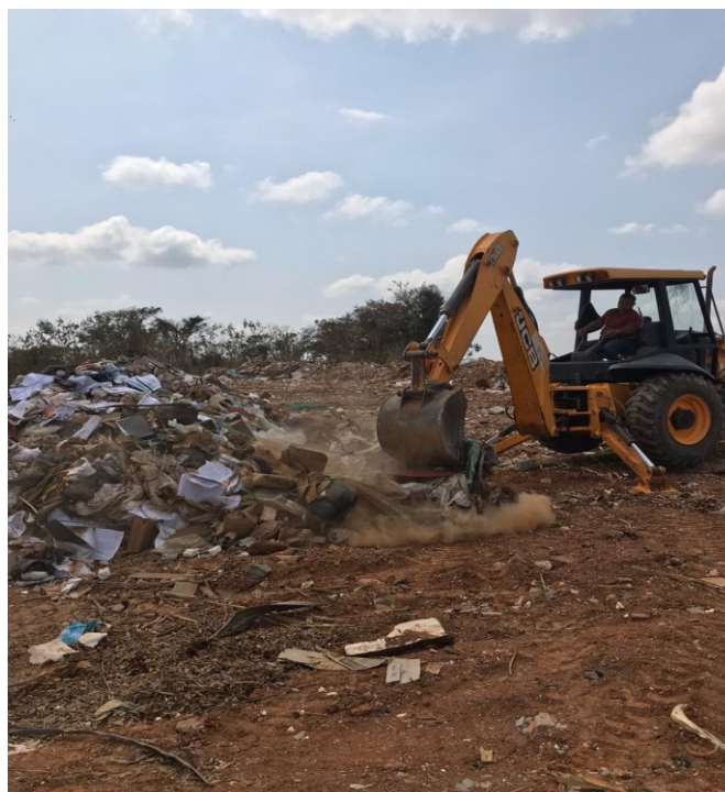
Figura 12 - Retroescavadeira utilizada no processo.
