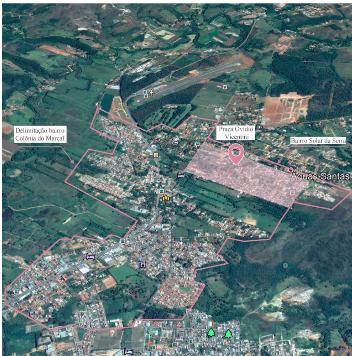
Figura 5 – Vista área do Bairro Colônia do Marçal e Loteamento Solar da Serra
