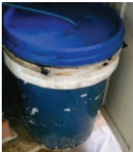
Figura 10 Tanque de acidificação e equalização (TAE) para alimentação dos reatores
