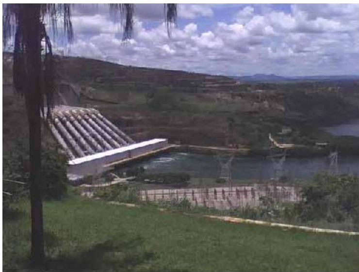
Figura 2 – Usina Hidrelétrica de Furnas.
