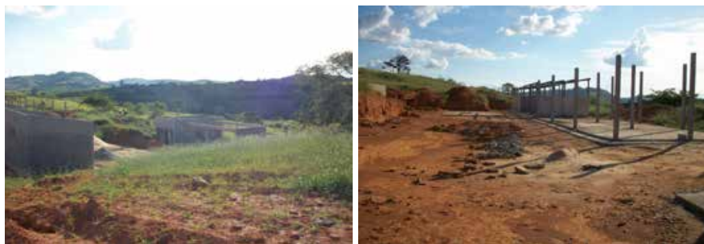
Figura 2 – Construção da Usina de Triagem e Compostagem na comunidade da Represa, Perdões, MG.
