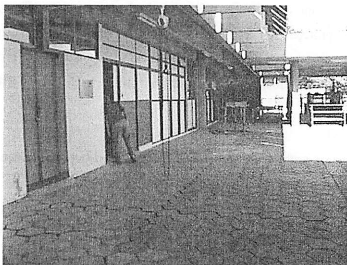
FIGURA 31 - Esquadrias face posterior do HV- Sala de cirurgia
