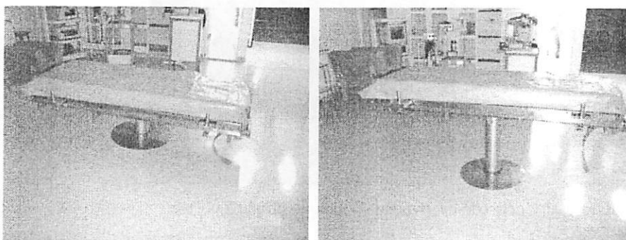
FIGURA 93 Elevador hidráulico da mesa de cirurgia
