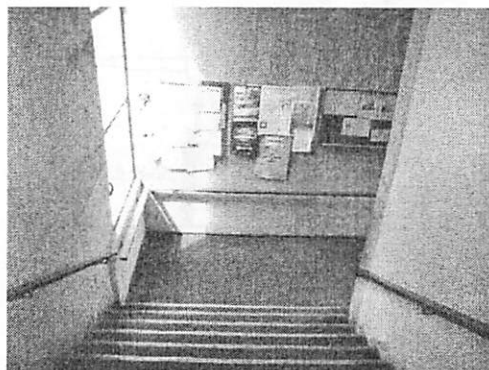
FIGURA 124 Escada principal HV
