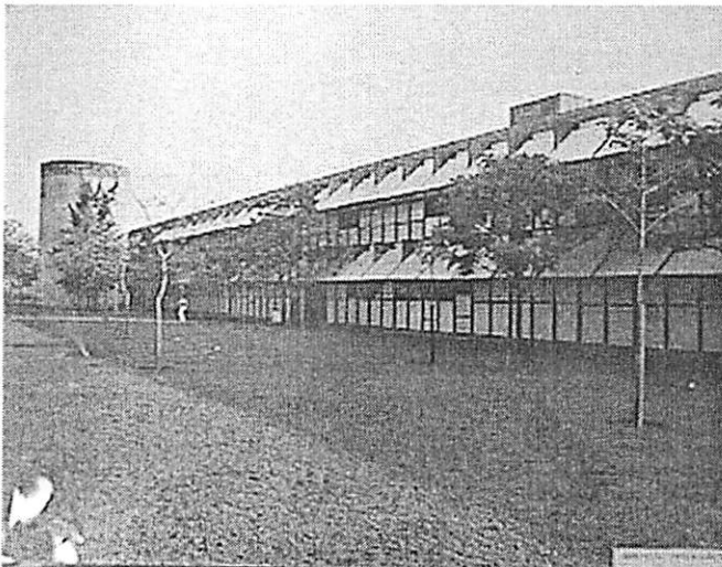
FIGURA 152 Foto final da obra 5
