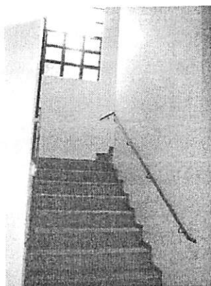
Figura 105 Acesso ao 2º pavimento da Clínica
