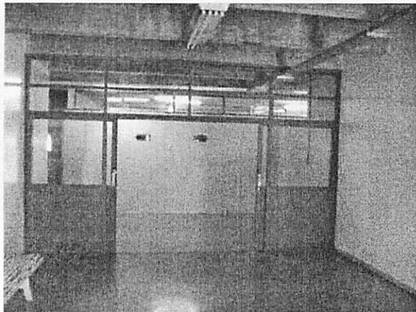
FIGURA 28 - Esquadrias de circulação e hall do 2º pavimento
