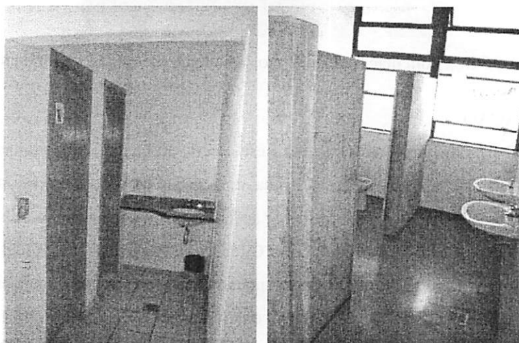
FIGURA 36 Sanitário Secretaria e sanitário masculino, segundo pavimento
