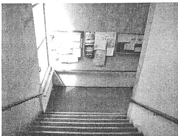
FIGURA 106 Vista escada segundo pavimento
