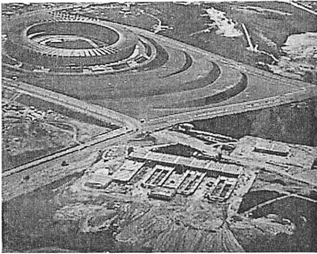
FIGURA 151 Foto do início da construção
