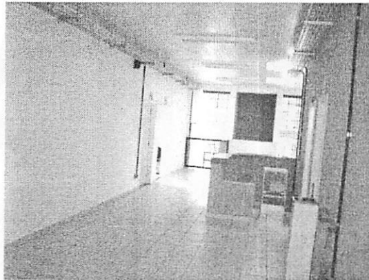
FIGURA 22 Piso segundo pavimento P.S. – cerâmico
