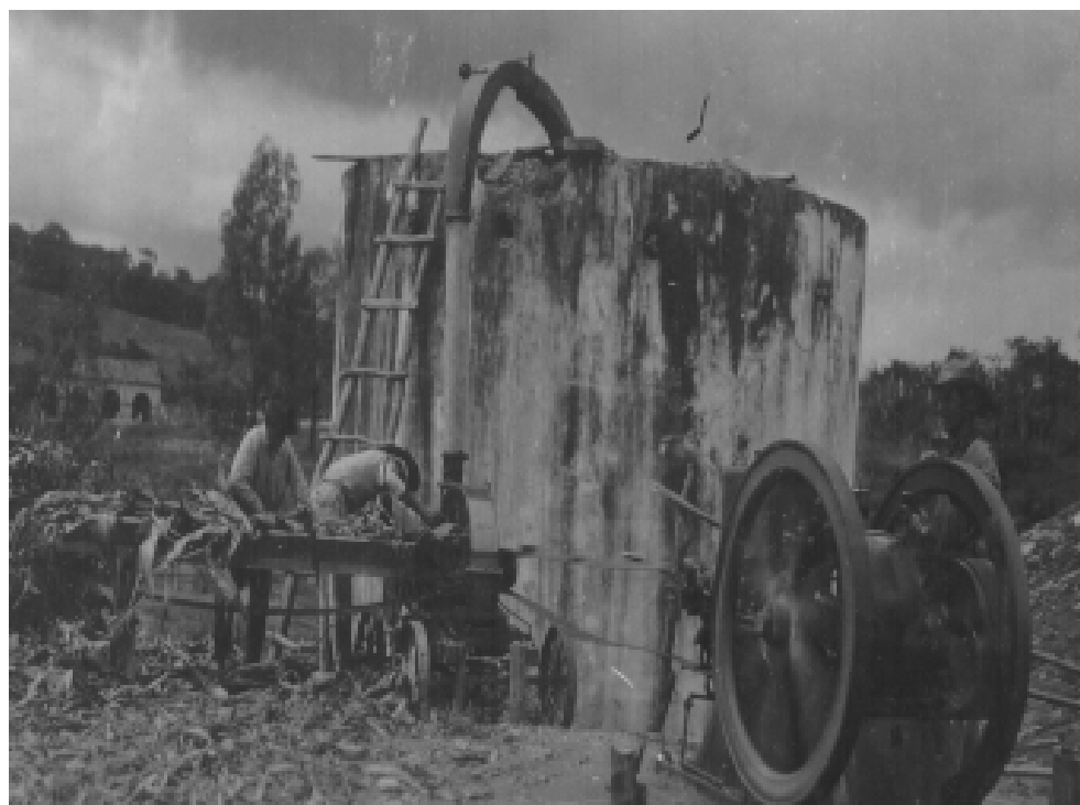
Primeiro Silo Aéreo em funcionamento
