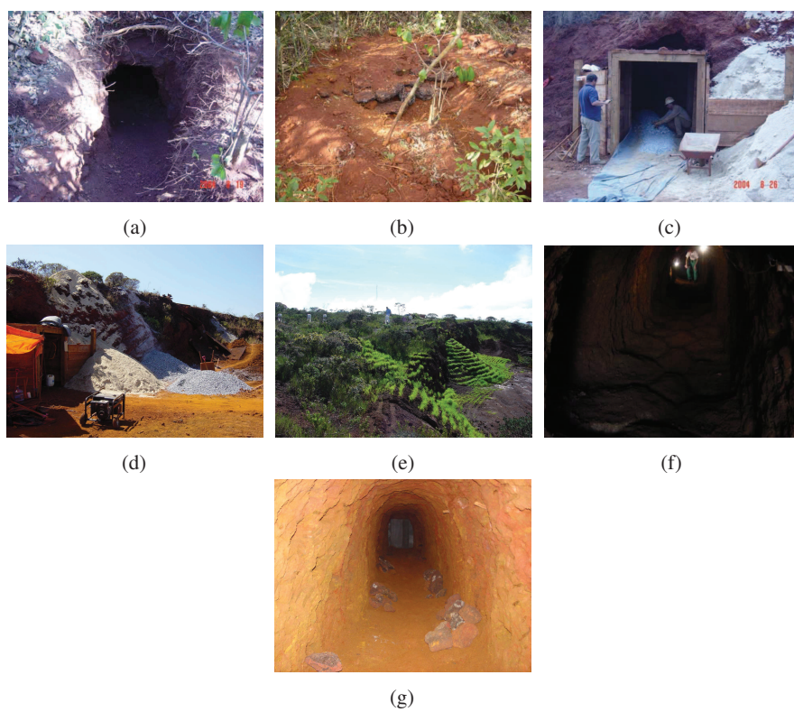
Figura 6 Principais etapas da construção da cavidade artificial. (a) e dique (b). Em (c) e (d) está representada a construção do dreno na porção final da cavidade, que posteriormente foi fechada (e). Reentrâncias feitas no piso do conduto (f) e chapas de aço dispostas ao longo da cavidade (g) Fonte: Rodrigo Lopes Ferreira
