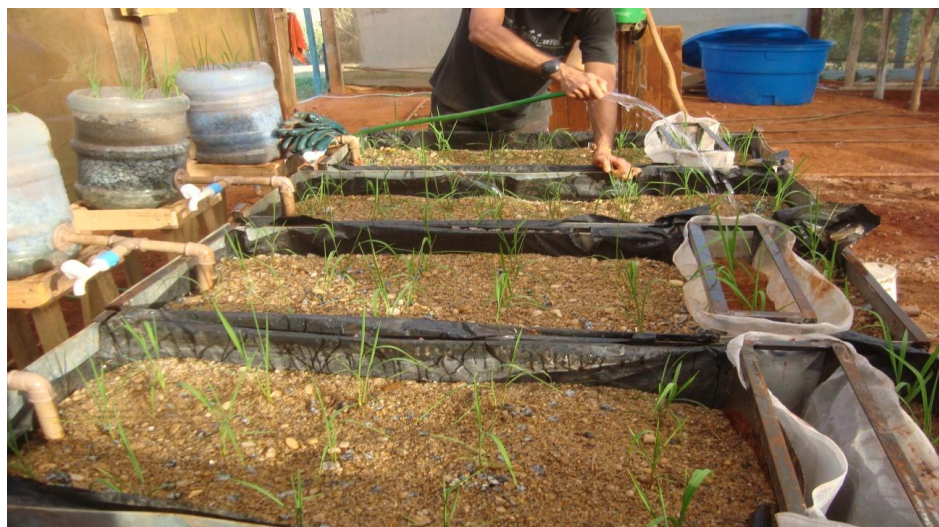
Figura 2 Detalhe do filtro inserido nos sistemas wetlands ainda em fase montagem
