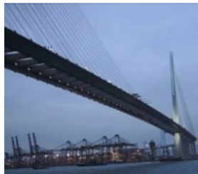
Ponte Stonecutters - Hong Kong - 58 acelerômetros
