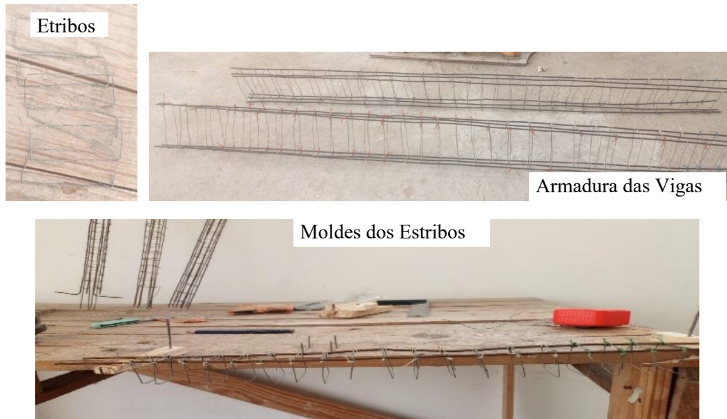
Figura 15 - Armação de Vigas.
