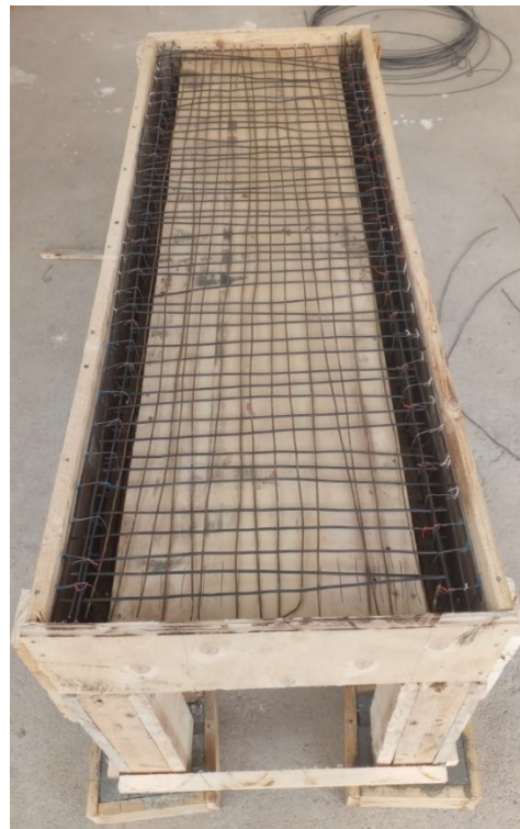
Figura 16 - Armação do Tabuleiro.
